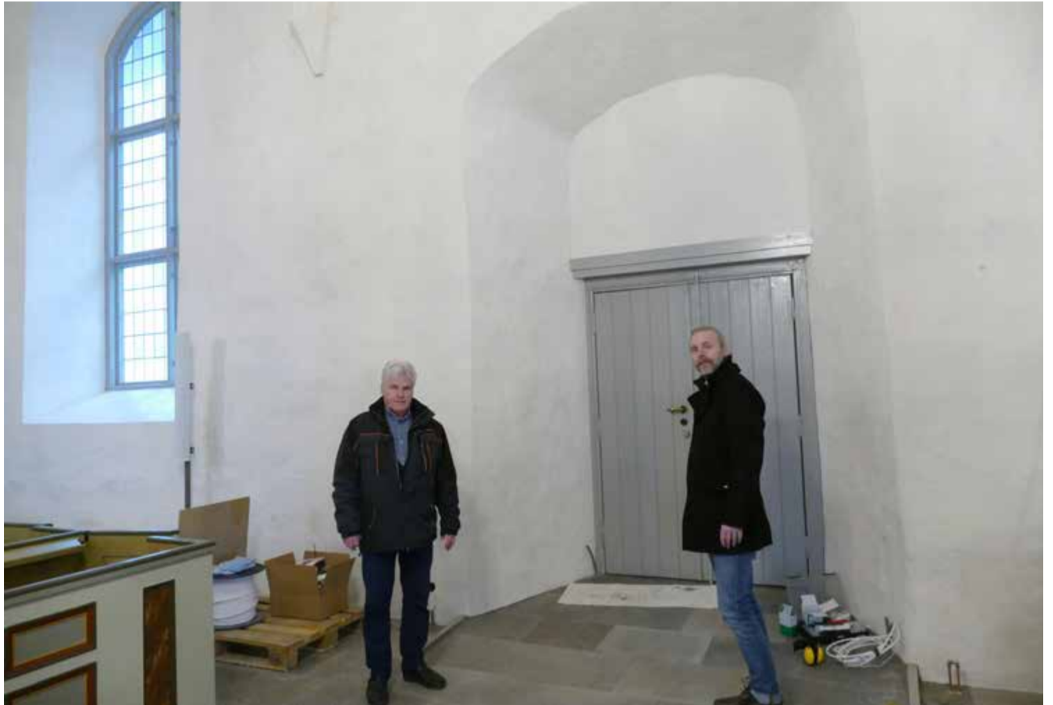
Det vindskydd som satt runt den här porten är borttaget. Mer ljus och en handikappanpassad ingång är några av fördelarna. Per Sverrin och Magnus Segendorff visar.
